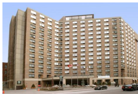
La nouvelle résidence McGill où se tiendra le salon du mois d'avril
